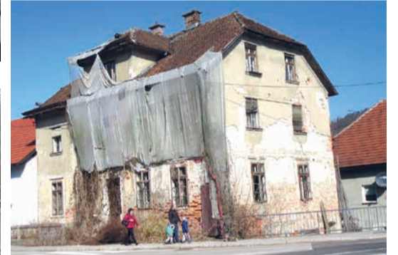
Razpadajoča hiša na Cankarjevi cesti, vezavi glavnega križišča pri savskem mostu
